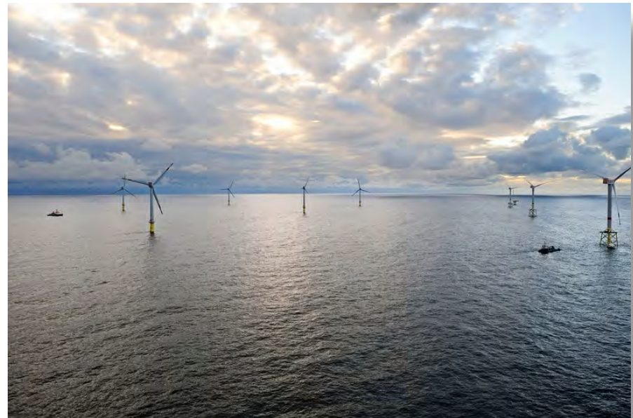
Foto: Deutsche Offshore-Testfeld und Infrastruktur GmbH & Co. KG Oldenburg
