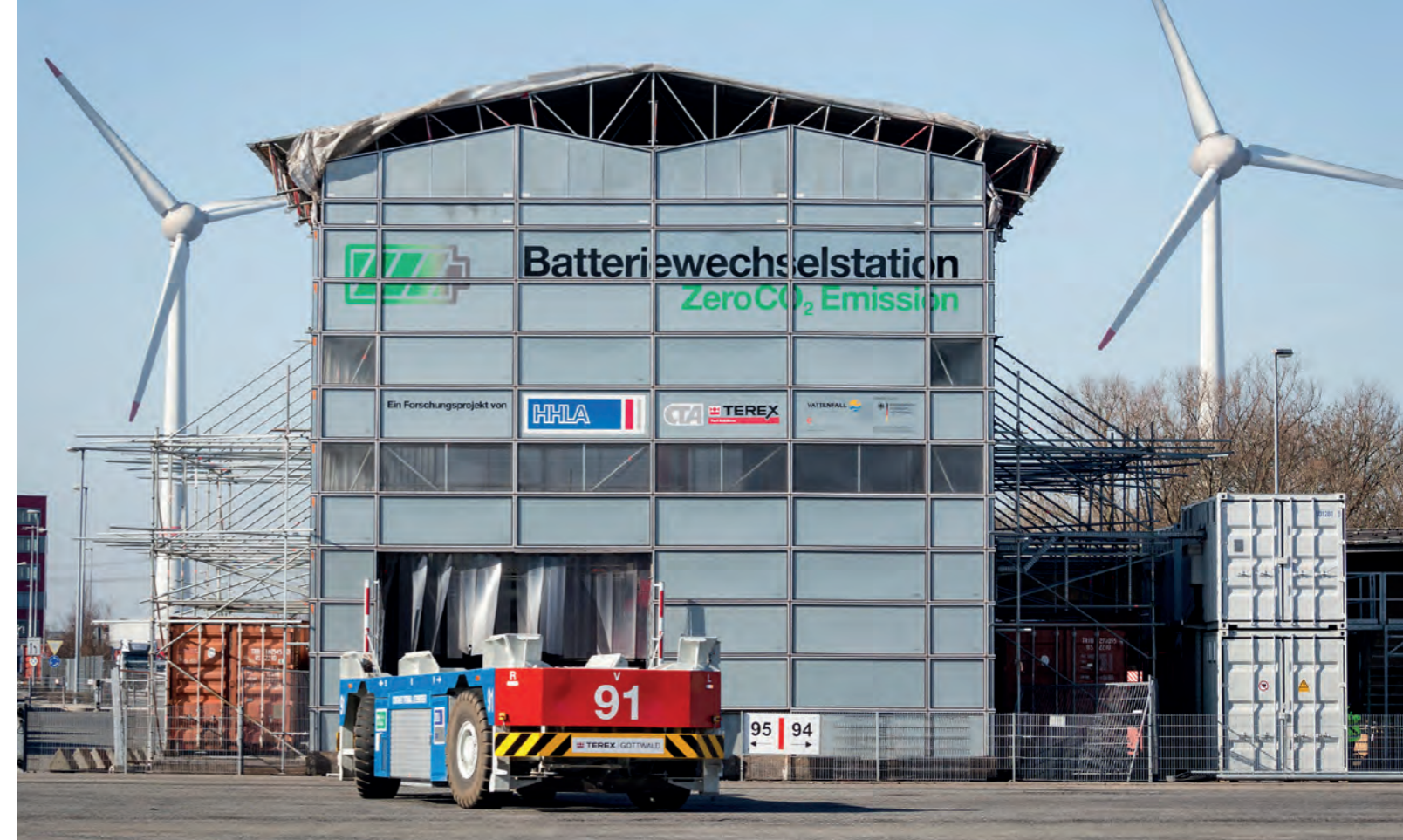
Forschungsprojekt BESIC am HHLA Container Terminal Altenwerder: In der Batteriewechselstation sollen die Batterien der selbstfahrenden Schwerlastfahrzeuge mit Ökostrom-Spitzen geladen werden.
