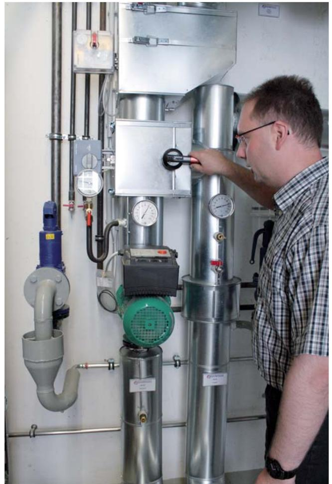
▲ Die hauseigene KWKK-Anlage (Kraft-Wärme-Kälte-Kopplung) des EFZN
